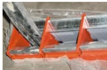
Рисунок 5. Монтаж модуля EZ-Path.
